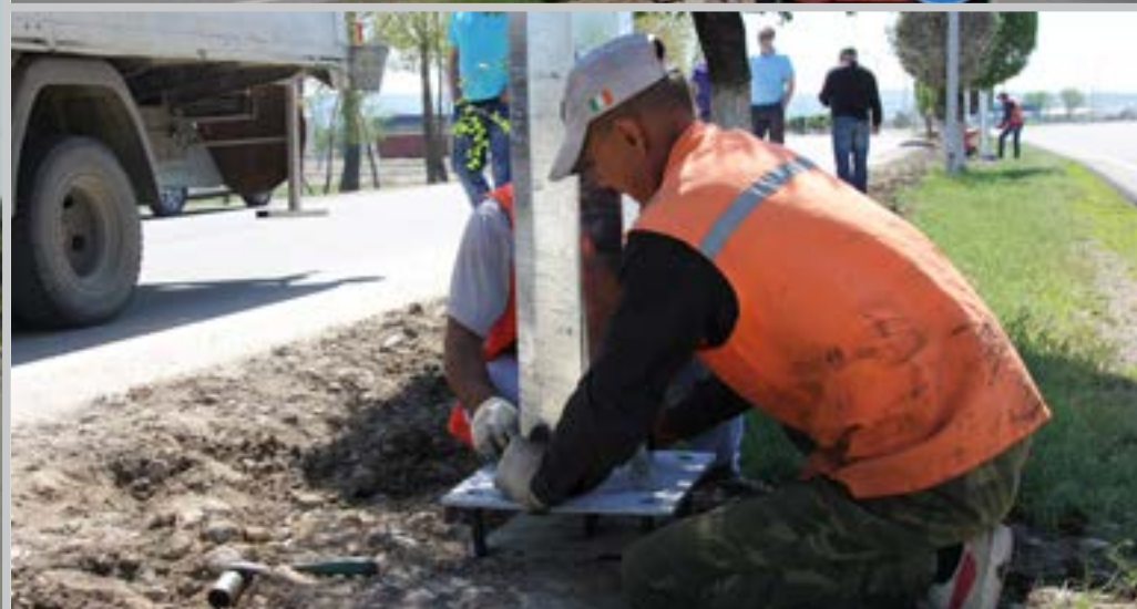
МОНТАЖ ОПОР ОСВЕЩЕНИЯ
